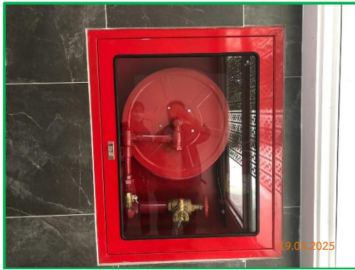
ภาพที่ 2-7 ตู้เก็บอุปกรณ์ดับเพลิง
